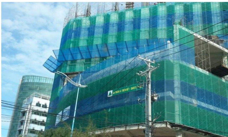
Hình 3. 1. Mô hình lưới chống bụi trong xây dựng được ứng dụng thực tế
